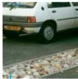
Tranchée d'infiltration
