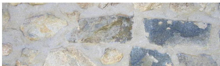
Moellons de pierre avec enduit « à tête nue »
