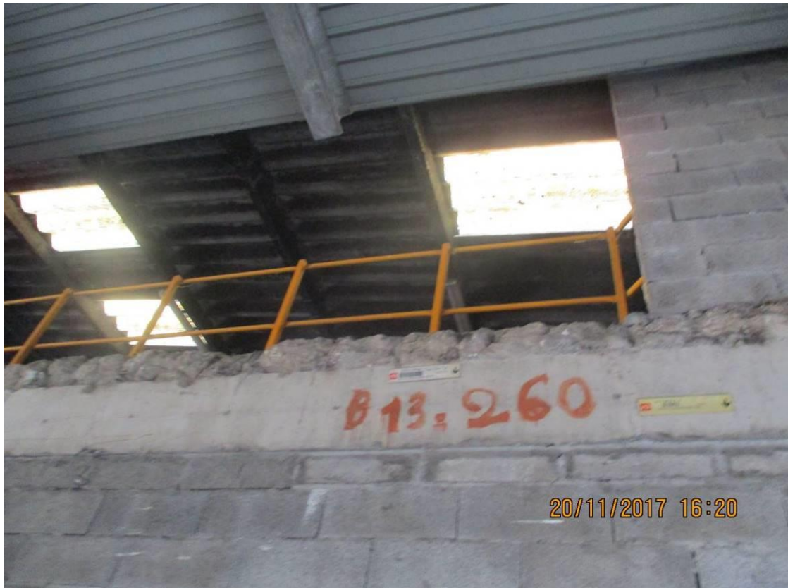
Partie en moellon avec mezzanine du bâtiment Ouest
