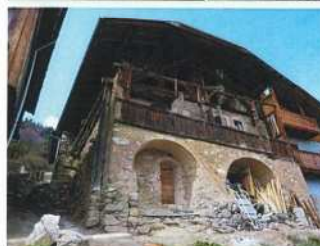
Très belle exemple d'enduit à la chaux et à pierre-vue.
