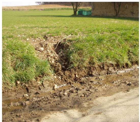
Effondrement d'un talus et dépôt de boue sur la route
