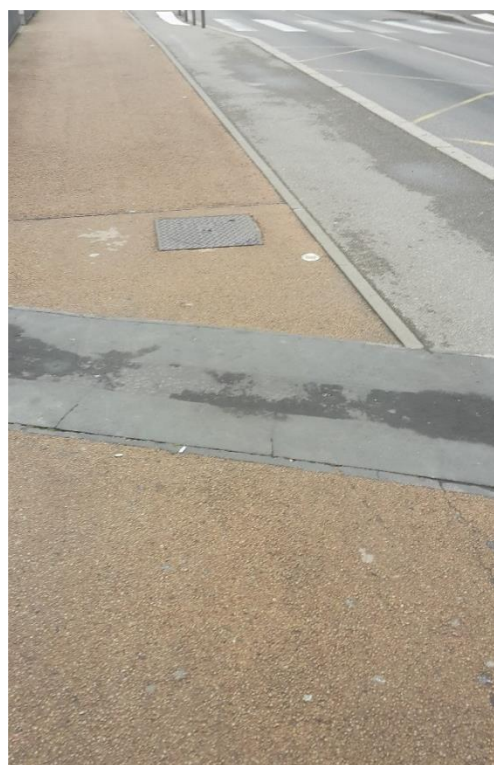
Enrobé poreux sur la piste cyclable du tram T3, Vaulx-en-Velin
