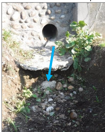
Photo n°2 – Consolidation du fond du fossé en sortie de canalisation et traces d'érosion
