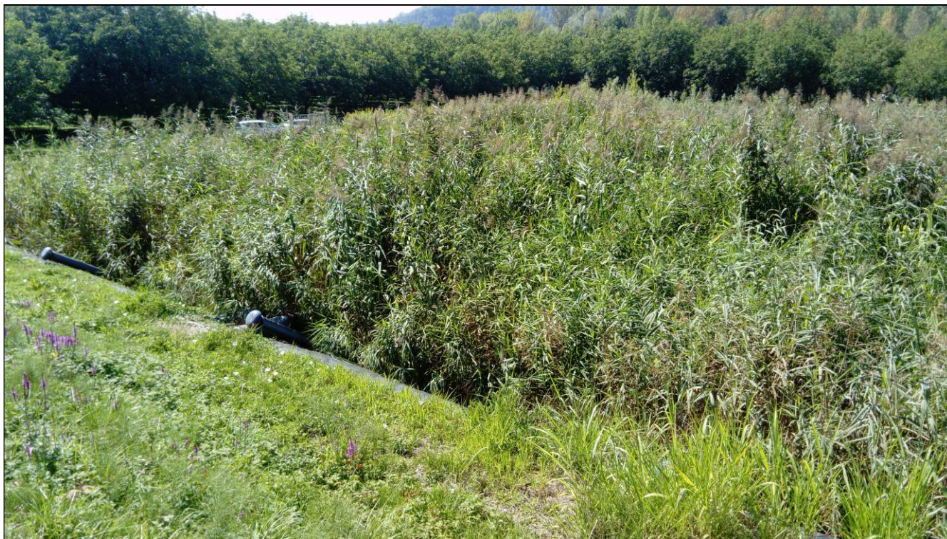
Deuxième étage des filtres plantés de roseaux
