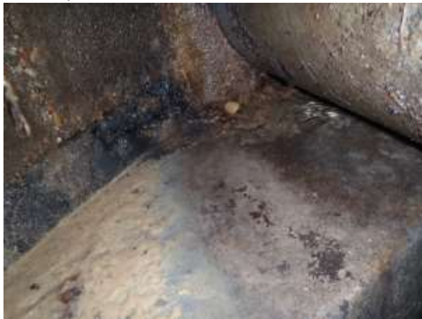
Infiltration sur branchement (n°155)
