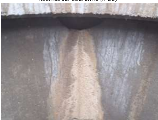
Couronne cassée et trace d'infiltration (n°44)
