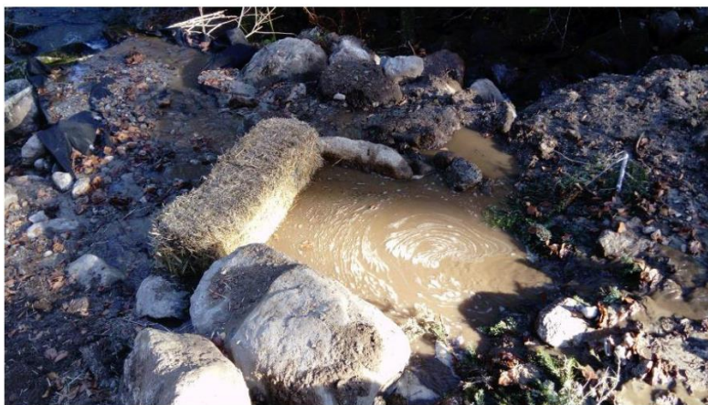
EXEMPLE DE FILTRE A SEDIMENTS MIS EN PLACE AU NIVEAU D'UN BASSIN DE RECUPERATION DES EAUX – AX LES THERMES
