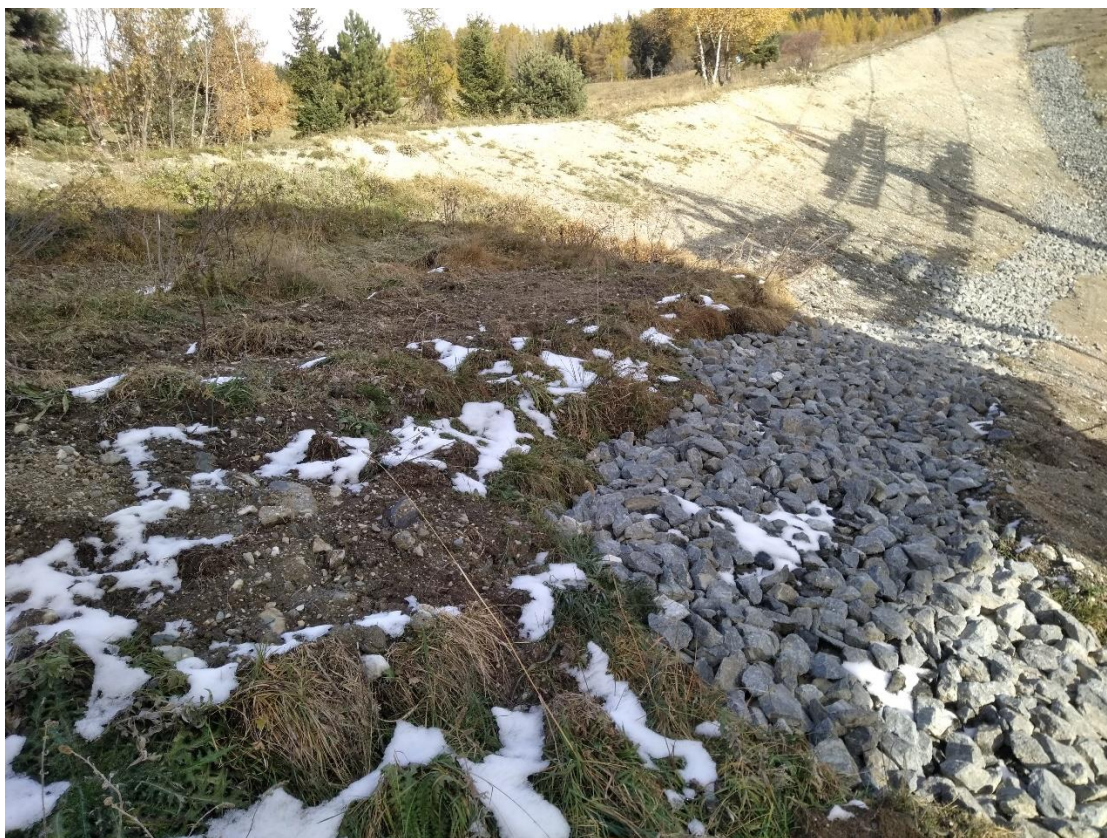
Drain mis en place en limite basse de la zone humide_KARUM
