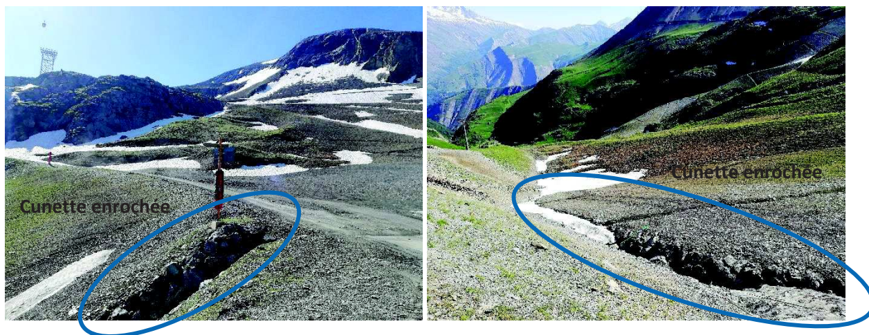
RUISSEAU EN ENROCHEMENT RÉCUPÉRANT LES ÉCOULEMENT DE VERSANT
