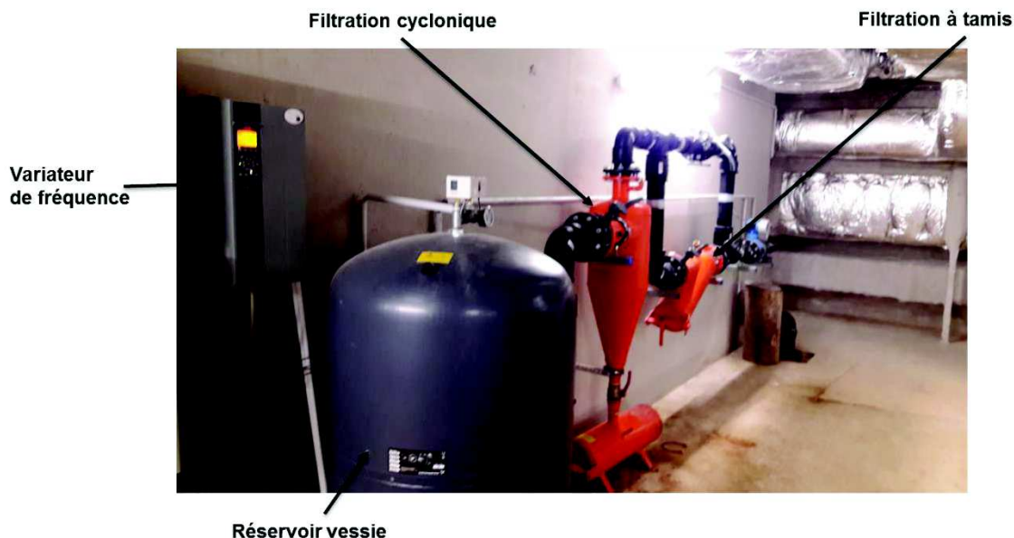
(37) Exemple d'équipement en local PAC pour la géothermie
