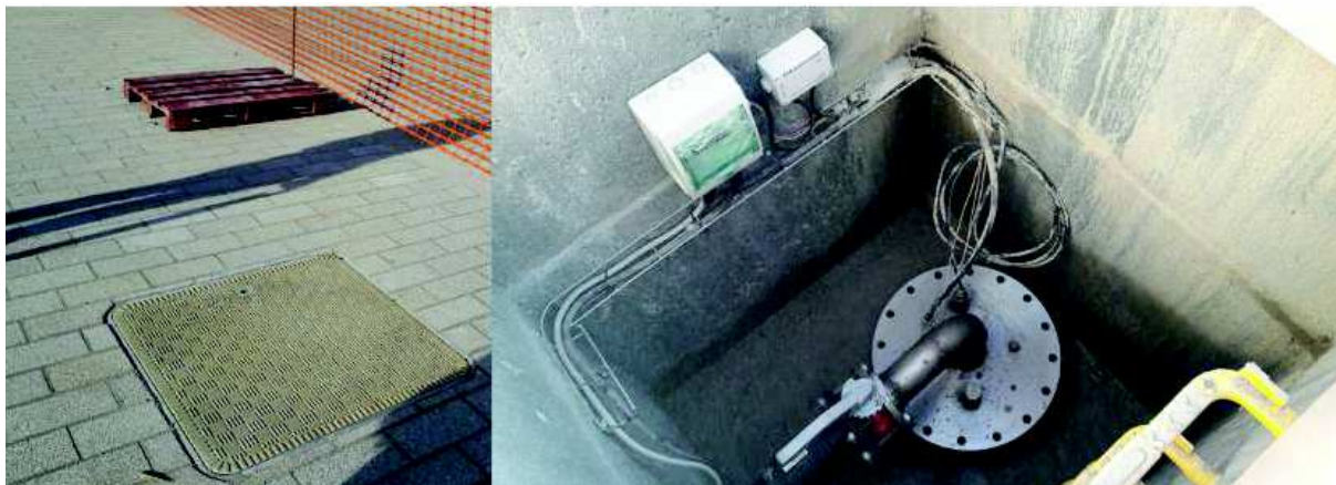
(36) Exemple d'un regard de forage de pompage géothermique
