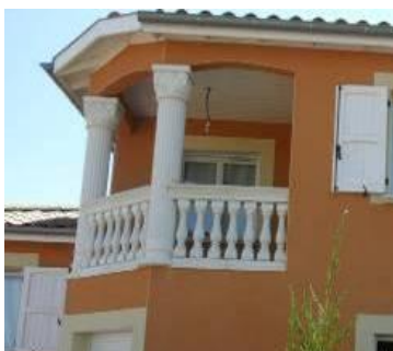
Type de balustres interdits
