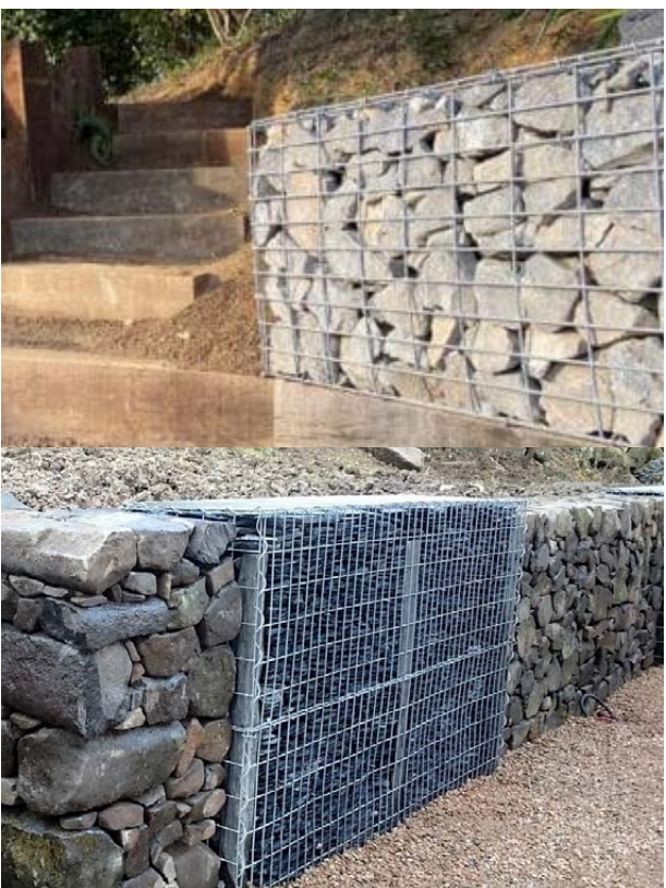
Reprise murs en pierre sèche avec gabions
