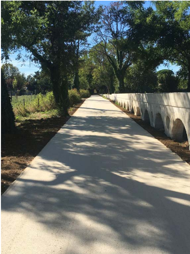
Stabilisé renforcé Cheminements piétons
