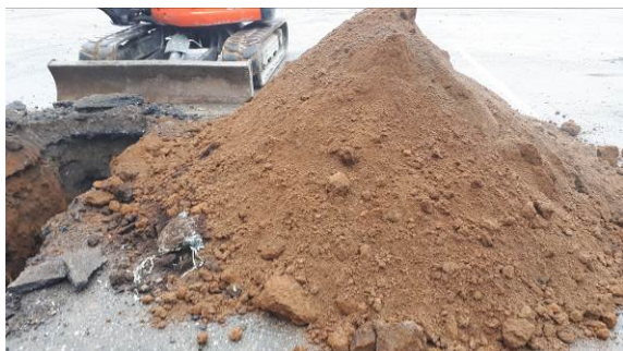
Figure 9 : Vue des limons sableux marron recoupés sous le niveau de remblais par le sondage PU3
