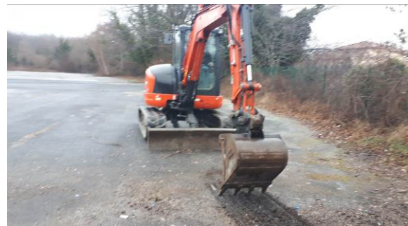
Figure 4 : Vue de la réalisation du sondage PU1
