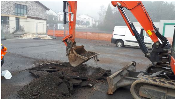
Figure 15 : Vue de la réalisation du sondage PU7
