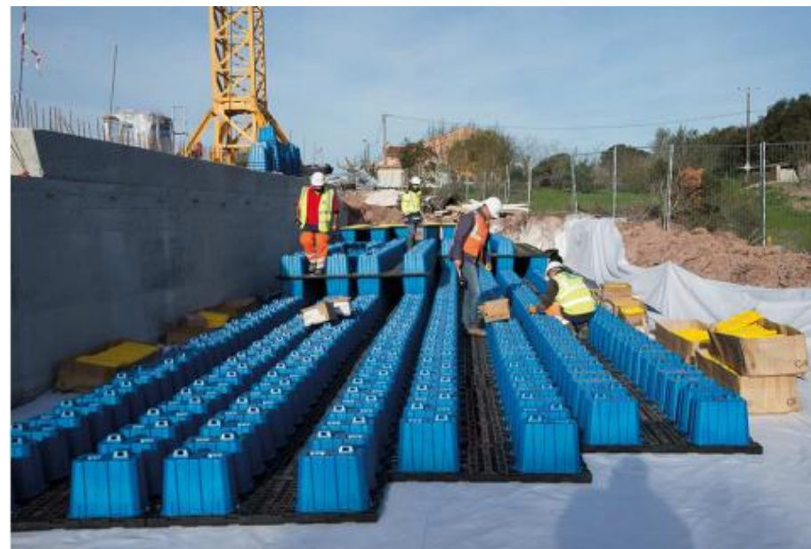
Figure 26 : bassin de rétention de type AZBOX
