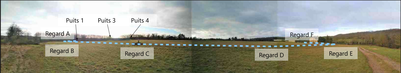
Les captages de Pr  Bonnet (galerie drainante avec 6 regards d'acc s et 3 puits exploit s)
