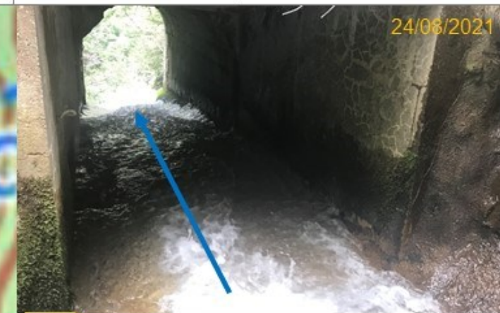
11 Passage sous la Route départementale : radier lisse sur les 7 mètres de franchissement de la RD 12
