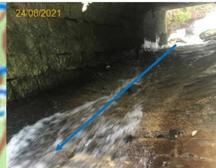
13 Passage sous la Route départementale : radier lisse sur les 7 mètres de franchissement de la RD12
