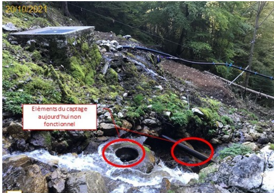
2 Vue depuis la rive droite du cours d'eau : Captage rive gauche avec conduite AEP apparente et ouvrages en béton du captage aujourd'hui désuet – En arrière plan, le flexible mis en place en aout 2021 lors des travaux d'urgence du captage
