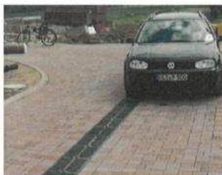
Figure 48 : Exemple de caniveau filtrant infiltrant (Funke)
