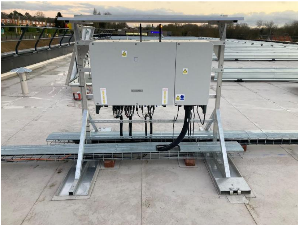
Figure 4 : Onduleur en toiture
