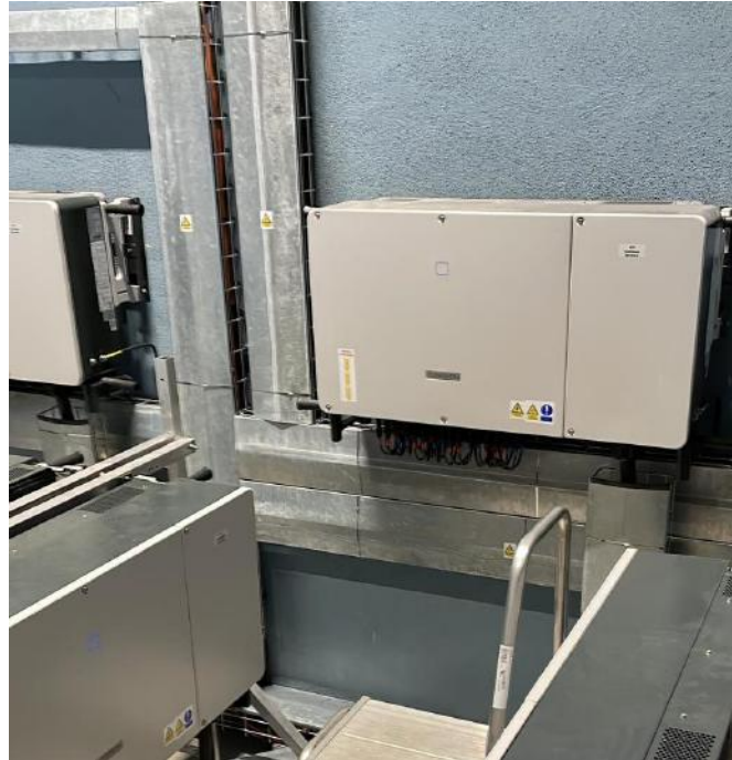
Figure 7 : Local onduleur avec cheminement capoté de câbles DC
