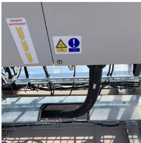
Figure 10 : Signalétique sur onduleur
