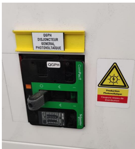
Figure 12 : Signalétique sur le disjoncteur général photovoltaïque
