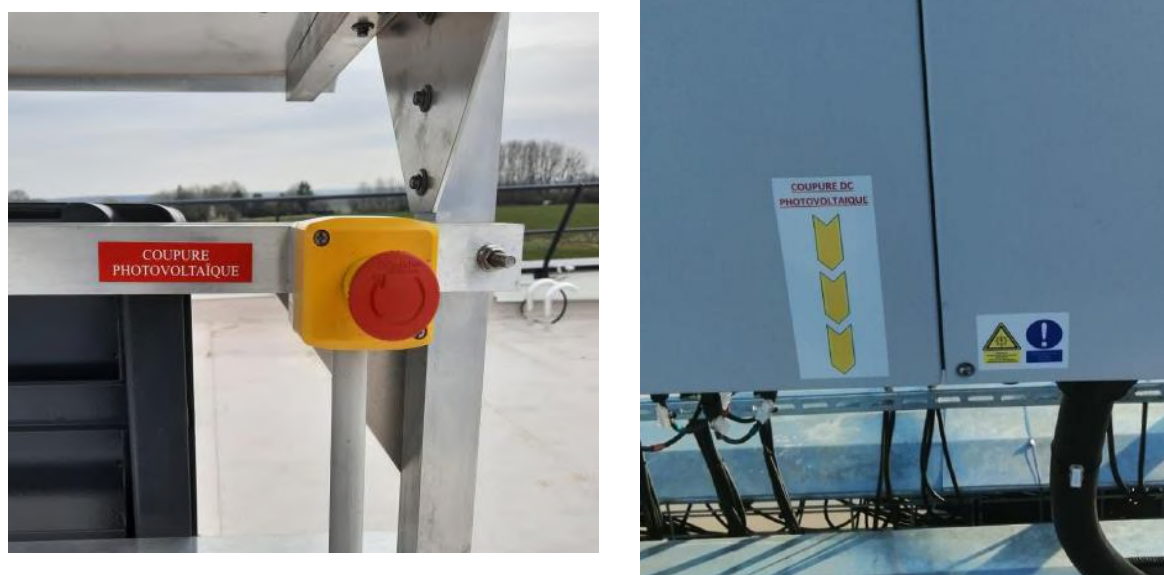
Figure 9 : Coupures photovoltaïque en toiture AC & DC
