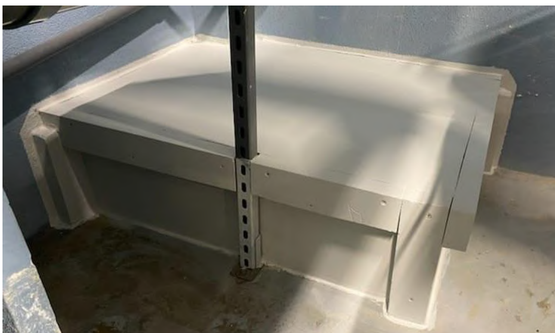
Figure 6 : Encoffrement coupe-feu 2h pour passage de câble DC dans le bâtiment
