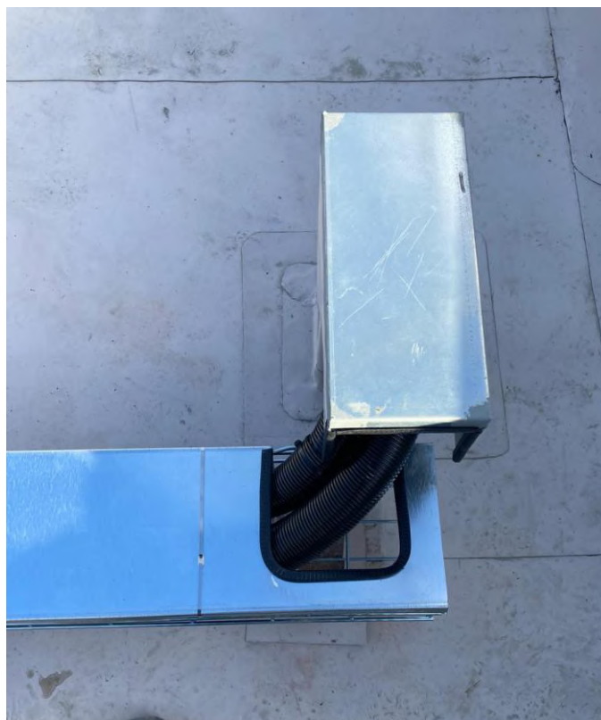
Figure 5 : Cheminement des câbles DC vers le local onduleur
