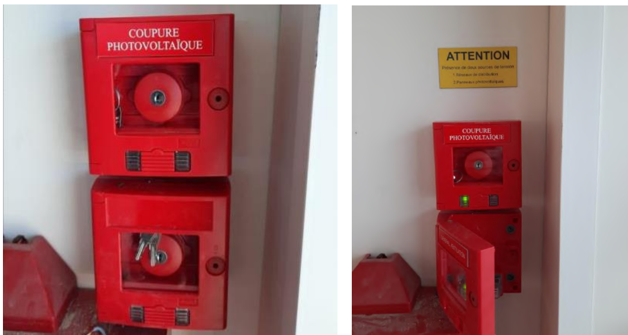
Figure 8 : Coupure générale PV et AU général à l'entrée du site
