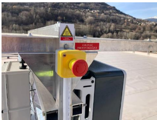
Figure 11 : Signalétique sur organe de coupure en toiture
