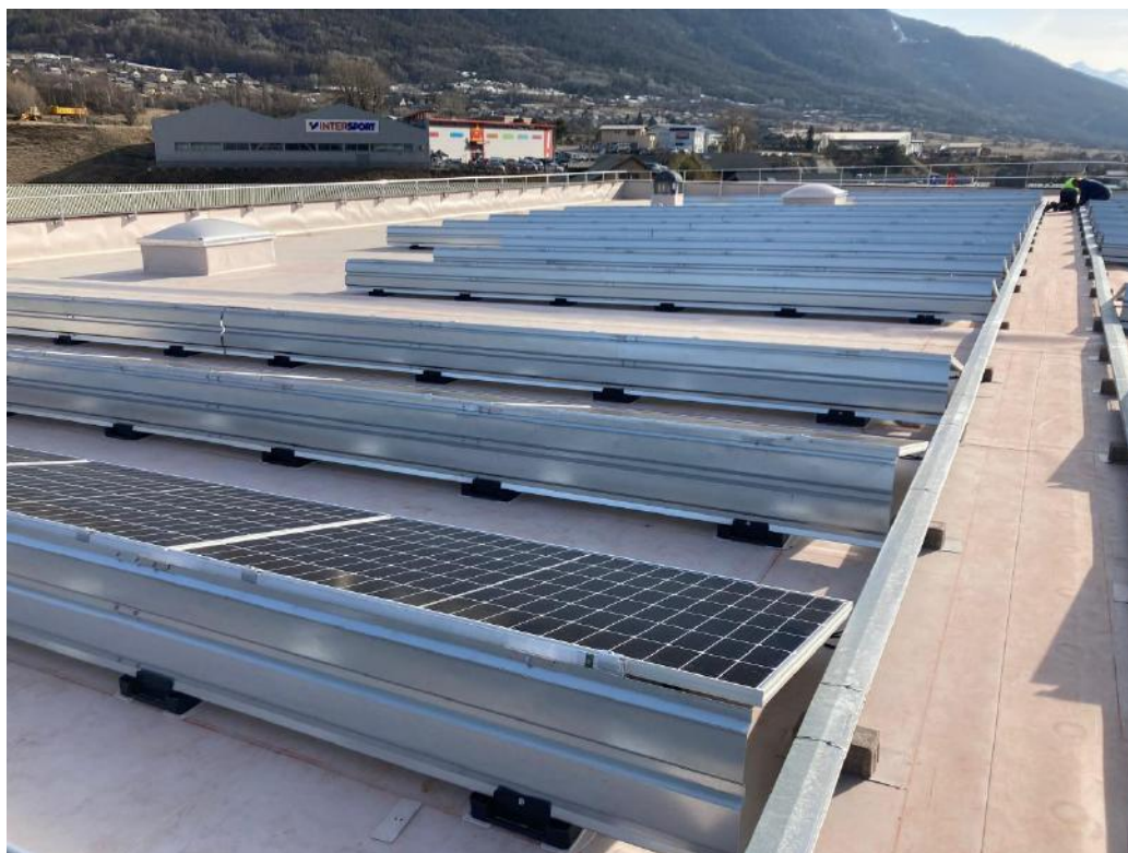
Figure 3 : Cheminement de 0,90 m au minimum et chemin de câble capoté
