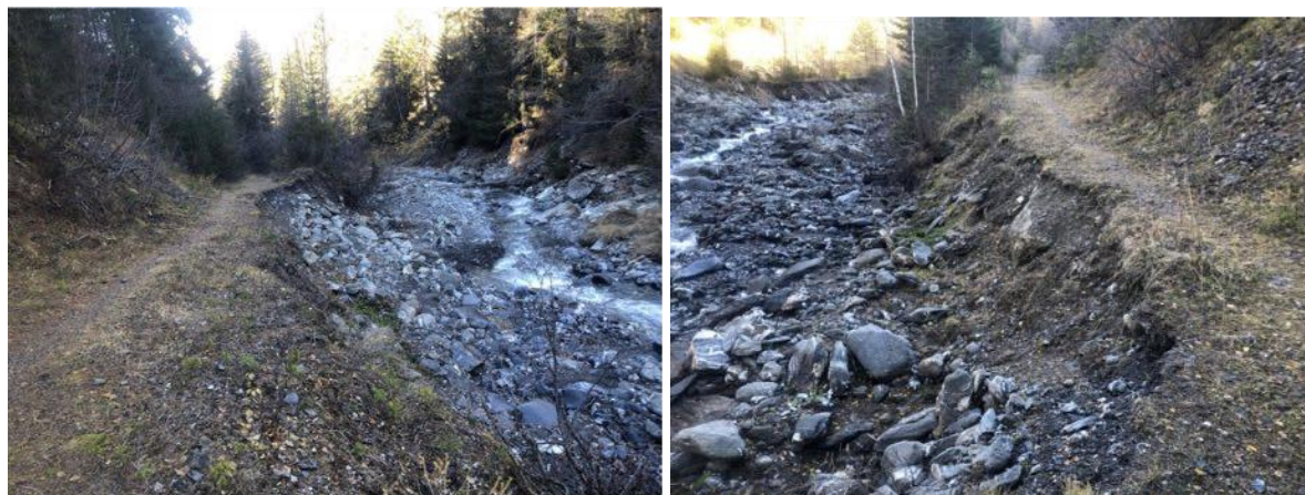
Figure 29 : Érosion sur piste carrossable (photos : SAGE Ingénierie)
