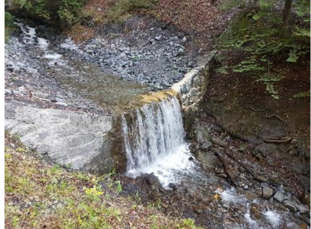
Seuil RTM (hauteur de chute > 2m) proche de la future restitution
