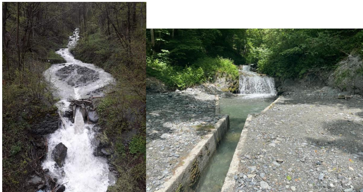
Figure 34 : a gauche : crue de mai 2021 et atterrissements dans la retenue amont du venturi ; a droite : régime hydrologique normal en juin 2021.
