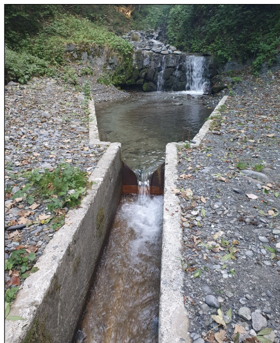
Zone d'implantation de la prise d'eau avec seuil RTM existant. Gauche : vue vers l'aval avec pont de la D82 à l'arrière plan ; droite : vue vers l'amont et seuil RTM (source : MTBE, 2021).
