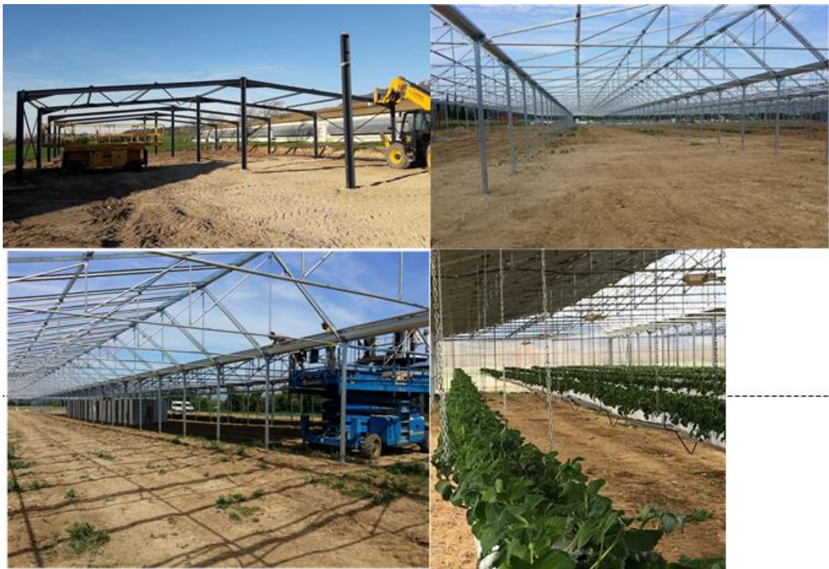
Figure 3 - Exemple de construction d'une serre photovoltaïque (Source : Générale du Solaire)
