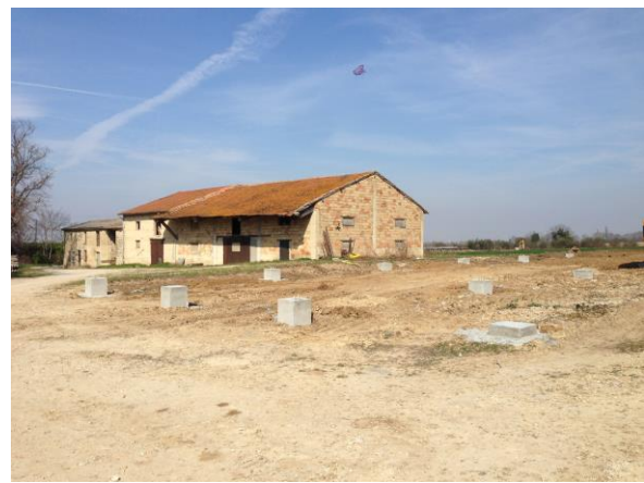
Figure 2 – Etapes du terrassement et pose des fondations des serres (Source : Générale du Solaire)
