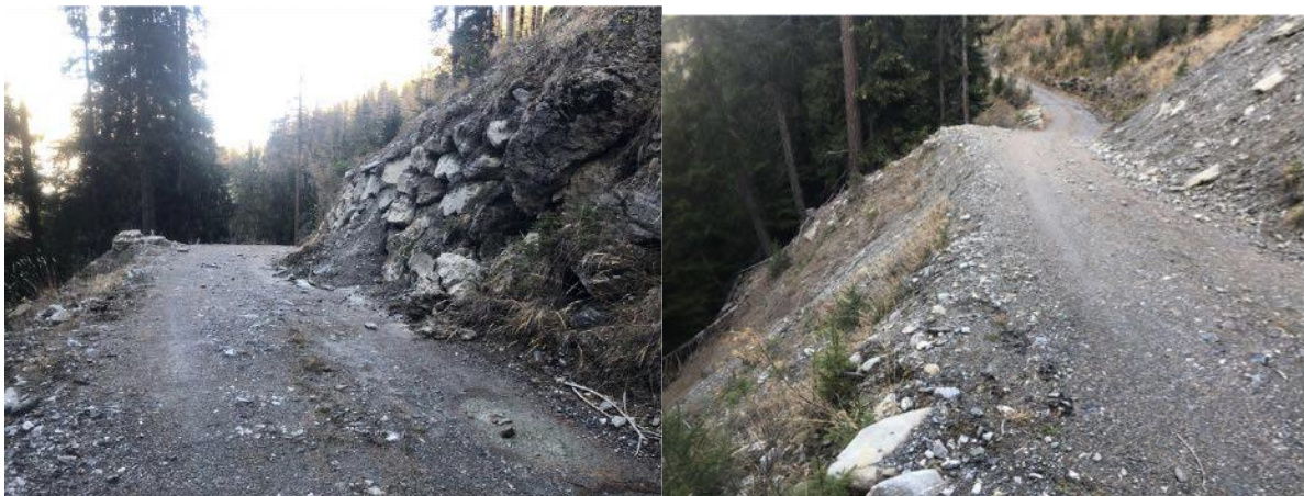
Figure 21 : Cheminement en rive droite du torrent et exemples de thalwegs qui canalisent les blocs vers le tracé (photos : SAGE Ingenierie).
