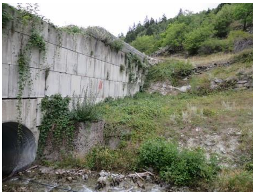
Figure 10 – Seuil de rétention des laves torrentielles (et de protection des avalanches) en amont des hameaux.
