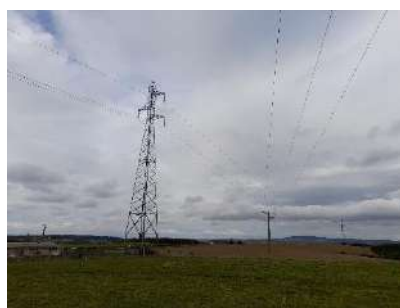
Photo 4 : Réseaux au droit du site (HTA à gauche et BT à droite) Source : ENOE 2022
