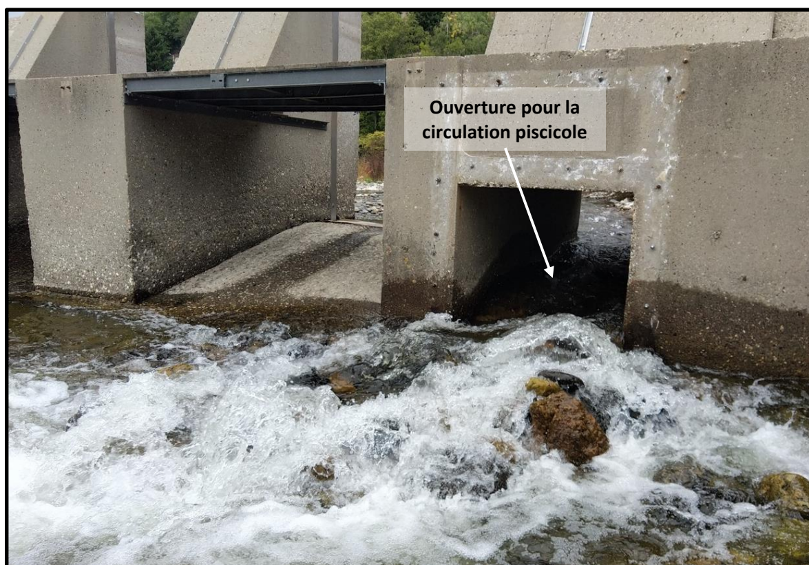
Figure 9 : Dispositif permettant le franchissement piscicole hors période estivale avec le plan d'eau vide
