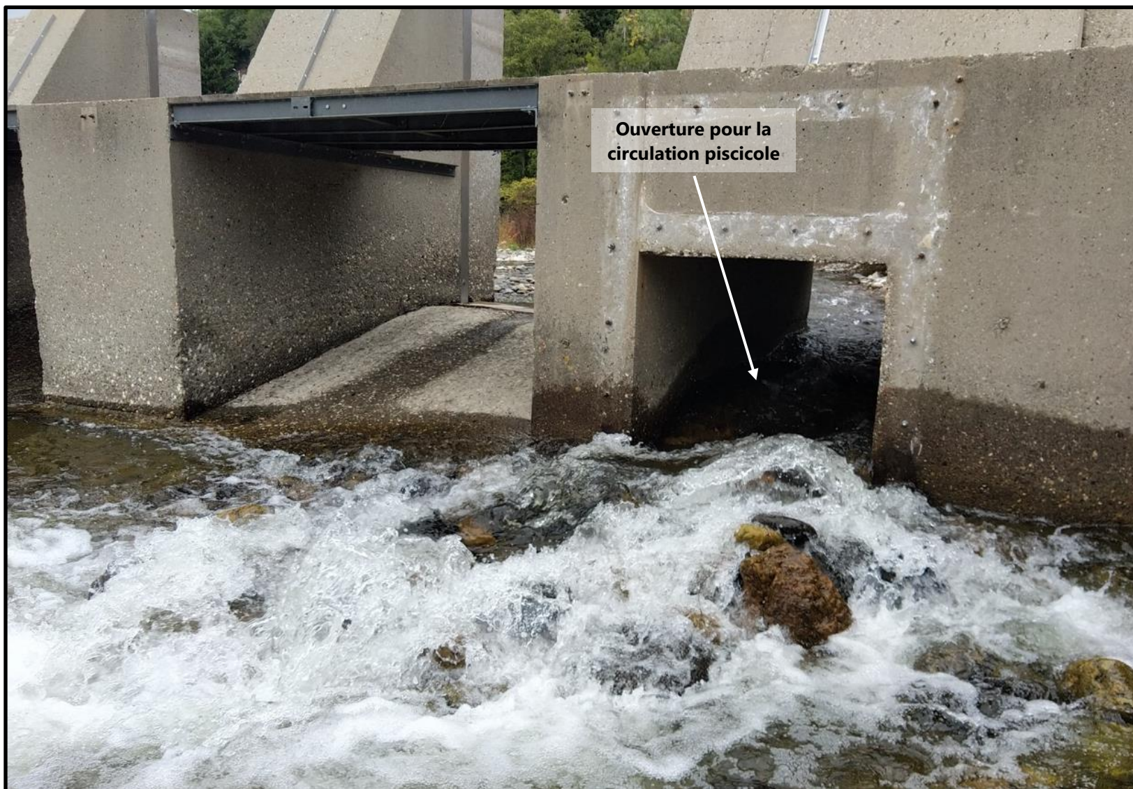
Figure 3 : Dispositif permettant le franchissement piscicole hors période estivale avec le plan d'eau vide
