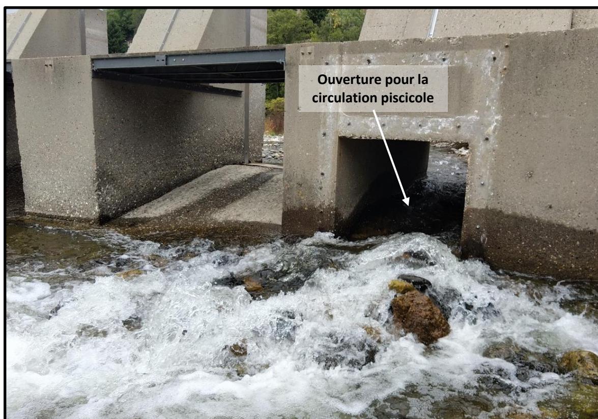
Figure 26 : Dispositif permettant le franchissement piscicole hors période estivale avec le plan d'eau vide
