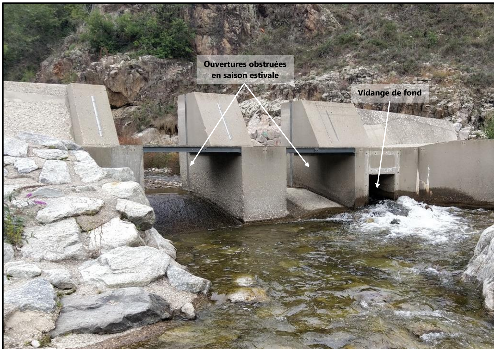
Figure 2 : Ouvertures en partie centrale et dispositif de vidange
