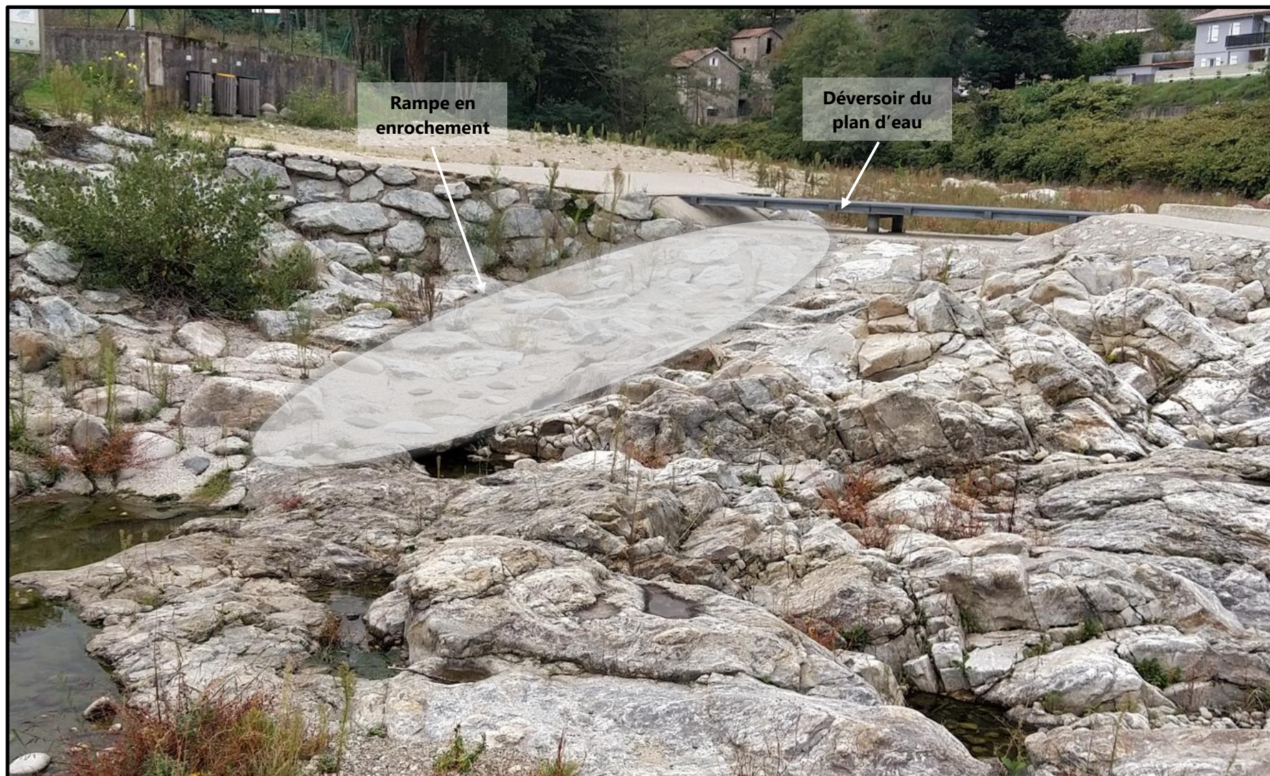
Figure 4 : Dispositif permettant le franchissement piscicole en période estivale avec le plan d'eau plein
