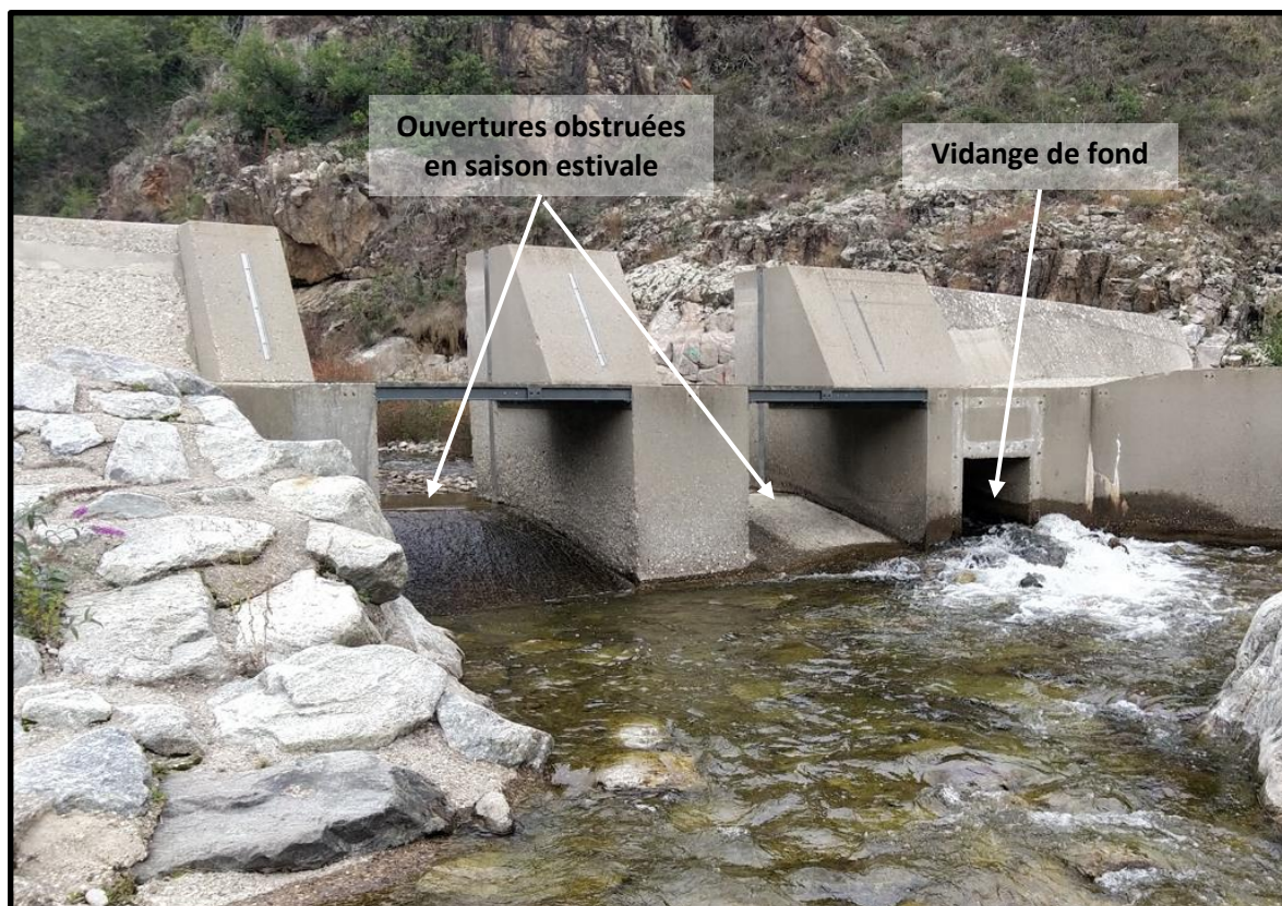
Figure 8 : Ouvertures en partie centrale et dispositif de vidange
