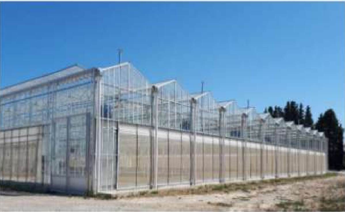
Aération par filet/bâche armée sur enroulement
