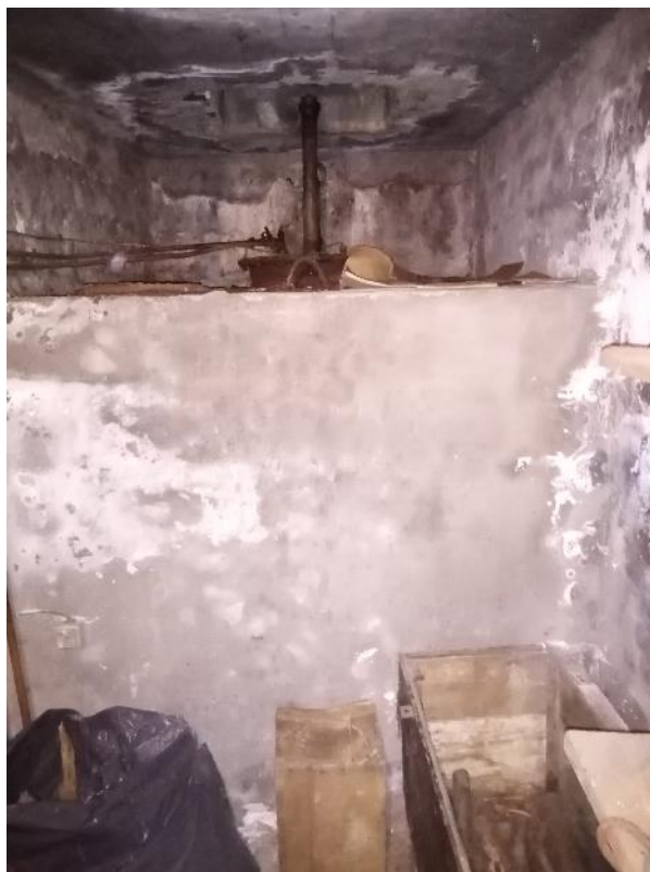
Cuve fioul en fosse maçonnée dans le local chaufferie
