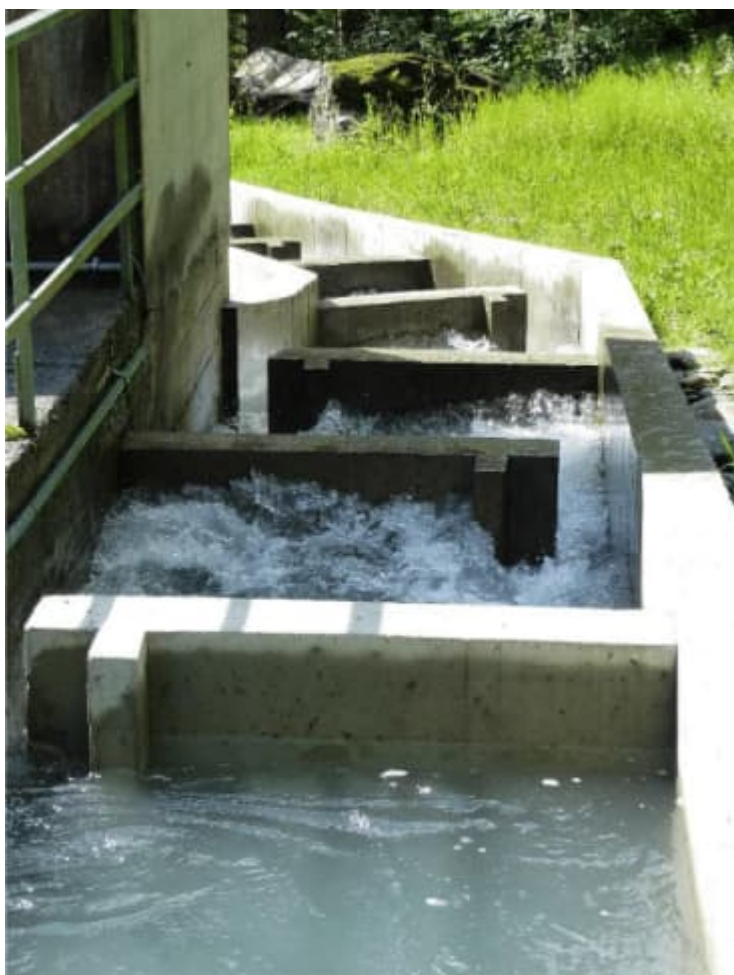
Photographie 4 – Passe à poissons centrale de Bonneval
