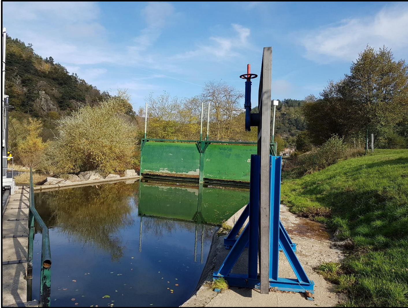
Figure 4 : Vannes de tête
