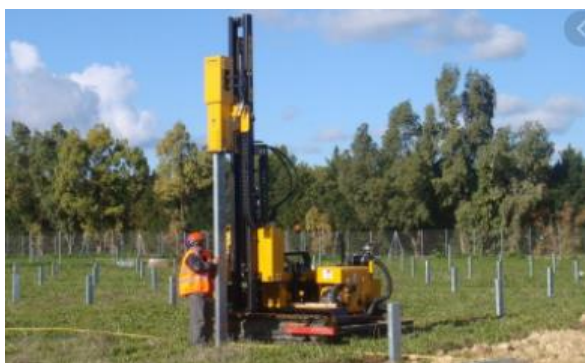
Figure 3. Ancrage des pieux battus
