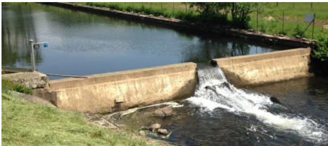
Illustration 3 : Seuil de la prise d'eau
