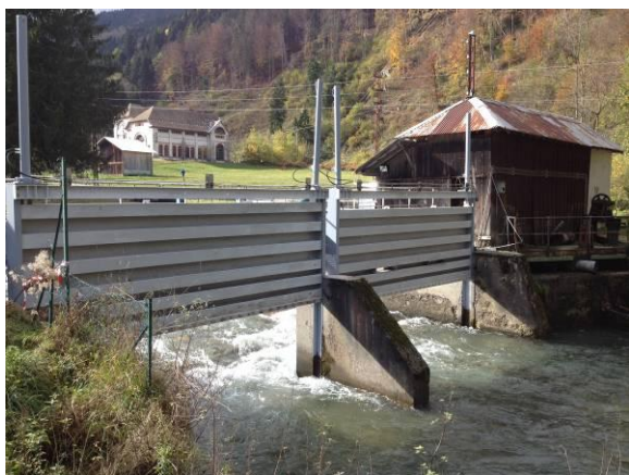
Vannes rivières de la PE de Riondet et délivrance du débit réservé
