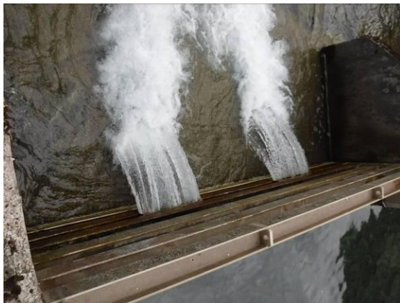
Vannes rivières de la PE de Riondet et délivrance du débit réservé
