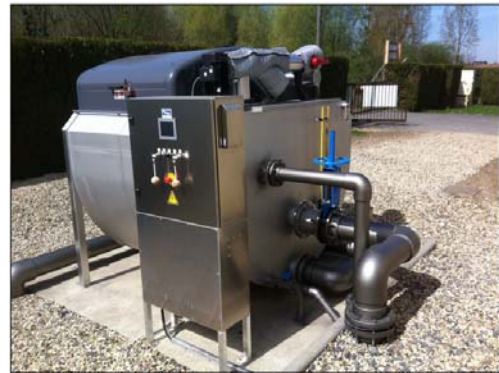
Figure 1 : photo d'un filtre tertiaire à disques rotatifs
