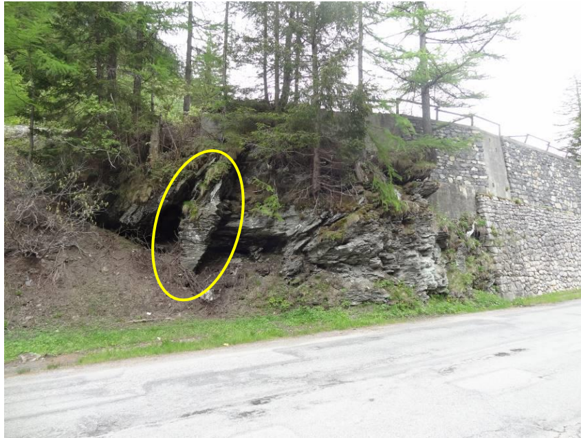
Figure 15. RD 87 E - Bloc à purger sous la plateforme de l'ancien hôtel du Rocher Blanc
