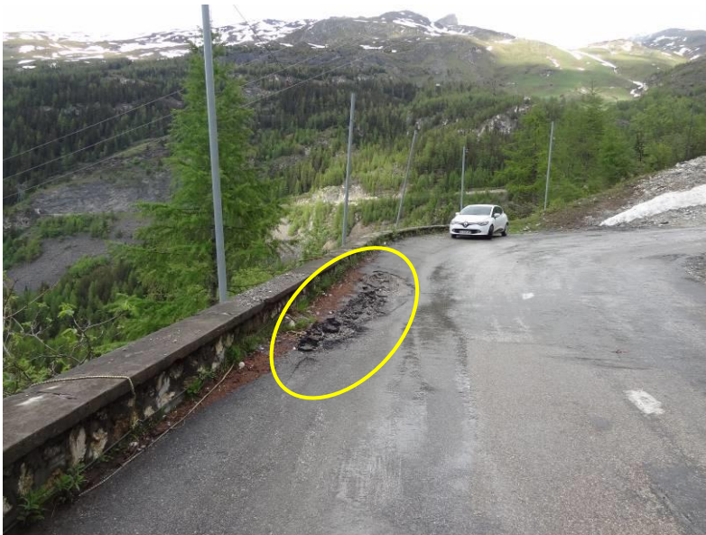
Figure 11. RD 87 E – Dégradation du bitume derrière un mur de soutènement
