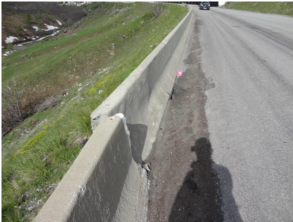
Figure 12. RD 87 A – Affaissement superficiel de l'accotement aval
