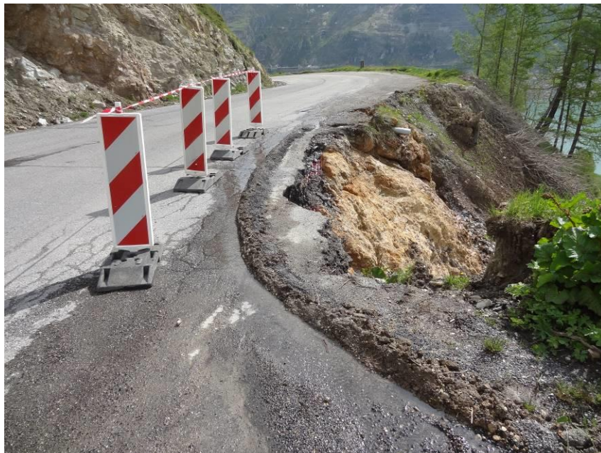
Figure 8. Erosion de la bordure de la RD 87A suite à l'avalanche du Glattier en avril 2018
