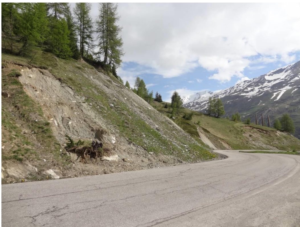
Figure 14. RD 87 A – Glissements/érosions superficiel(les) du talus amont
