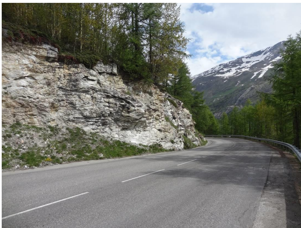
Figure 18. RD 87 A – Crête de falaise à purger
