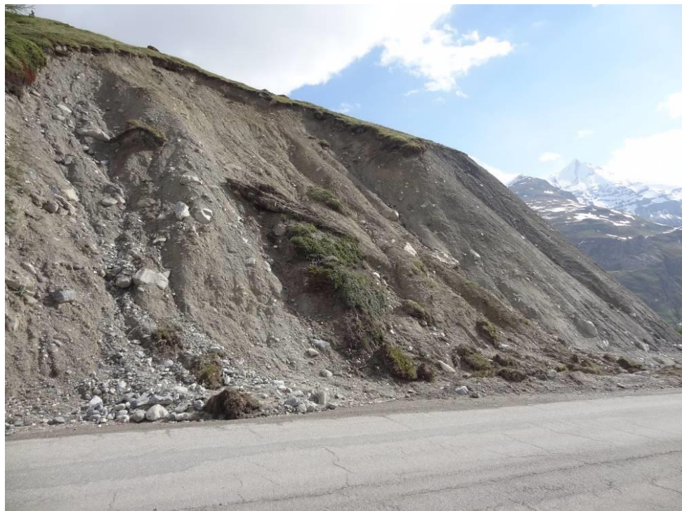
Figure 13. RD 87 A – Glissement superficiel du talus amont
