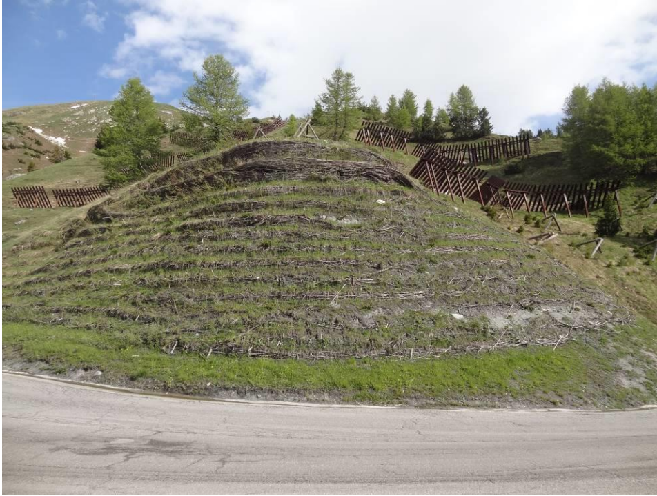
Figure 9. RD 87 A - Lutte anti-érosion par fascinage
