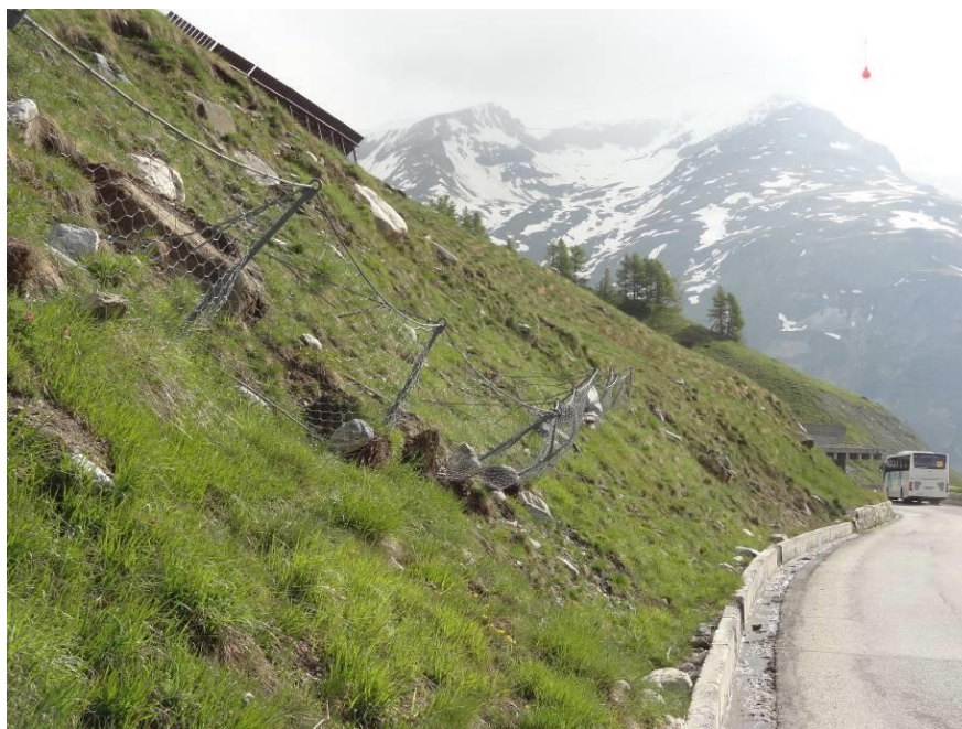
Figure 21. RD 87 A – Système anti coulée déformé constitué d'un grillage 60 x 80 mm monté sur barres GEWI 32 mm
