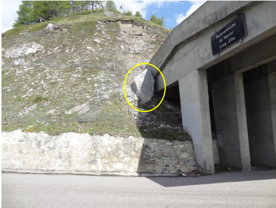
Figure 19. RD 87 A – Paravalanche du Vépier – Bloc à purger
