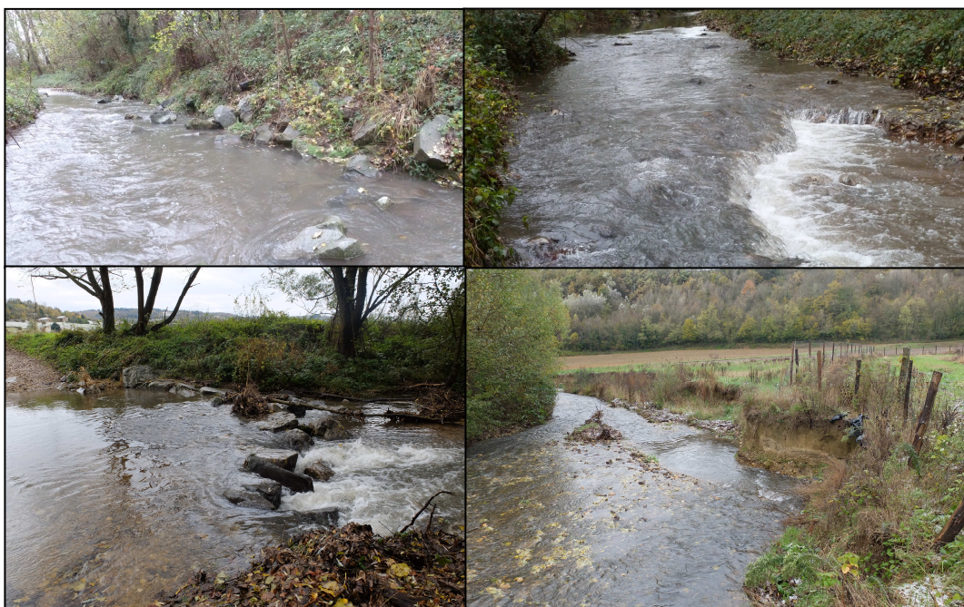
Figure 2 En 2017, les vestiges ou traces des interventions volontaristes passées sont toujours significativement présentes : enrochement en berge « basculant » par phénomène d'incision du lit (image haute et gauche), ouvrage de stabilisation du profil en long de type dalle de fond ou passage à gué en blocs (images haute et de droite, puis basse et gauche). Les fronts érosifs actifs actuels témoignent d'ailleurs des réajustements morphologiques dont la Gère fait encore l'objet (clichés Biotec, 2016).
