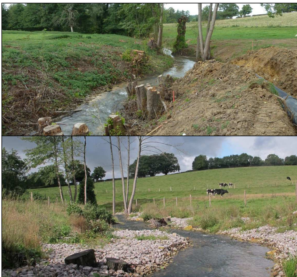
Figure 8 Illustrations d'une opération de restauration morpho-écologique de la Bèthune à Glinet (dept. 27), par réhaussement des fonds/rééquilibrage du profil en long, puis recréation de substrats adaptés. Photos, conception et maîtrise d'œuvre : équipe d'Ingénieurs de Biotec.
