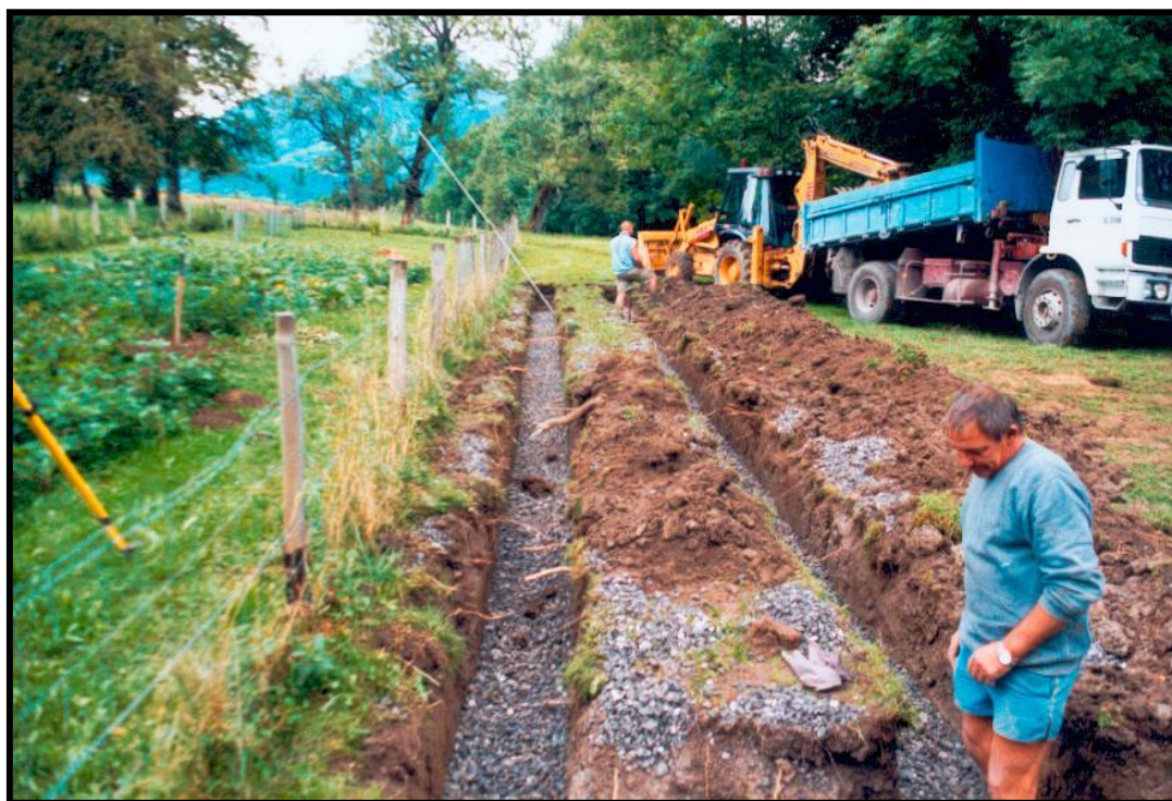
Tranchées d'épandage en cours de réalisation
