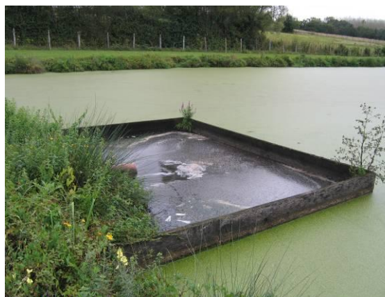
Arrivée des effluents en tête de bassin n°1 – dégraisseur rustique (cloison siphonoïde) Faible surverse - 16 septembre 2010
