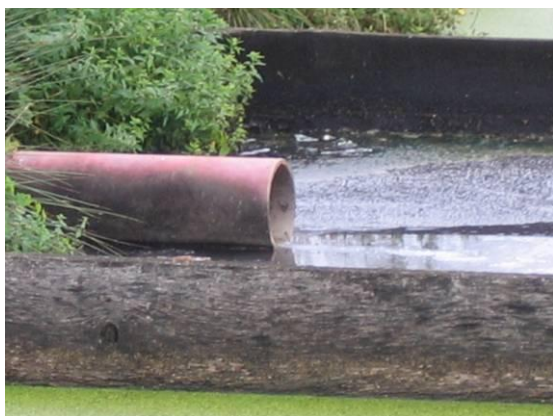
Arrivée des effluents en tête de bassin n°1 – dégraisseur rustique (cloison siphonoïde) Faible surverse - 16 septembre 2010
