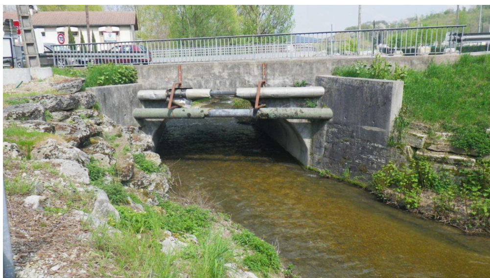
Photo illustrant les conduites sur la face amont du pont.
