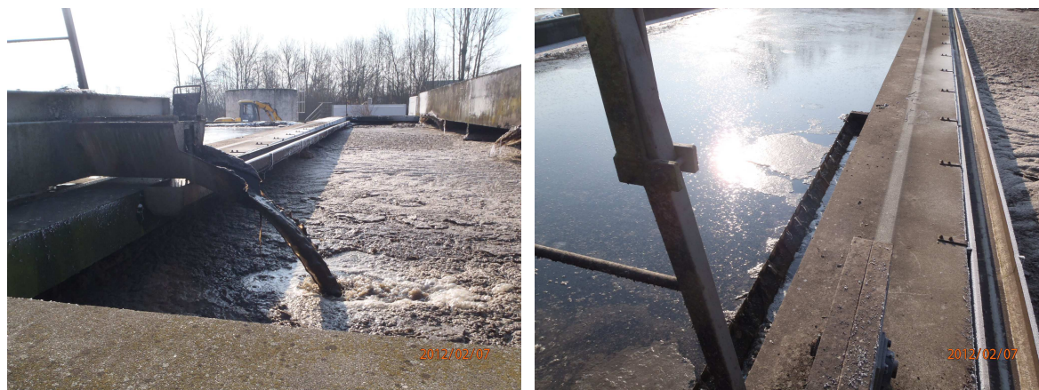
Illustration 5 : Clarificateur et recirculation des boues
