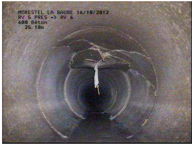
Effondrement partiel sur Ø600 Béton (secteur La Baube)
