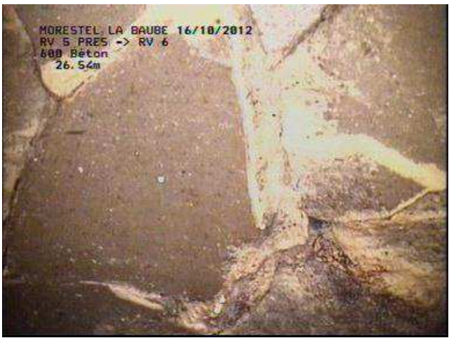
Effondrement partiel sur Ø600 Béton (secteur La Baube)
