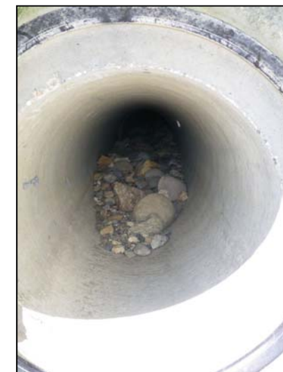
Obstruction du réseau Ø500B par les matériaux charriés
