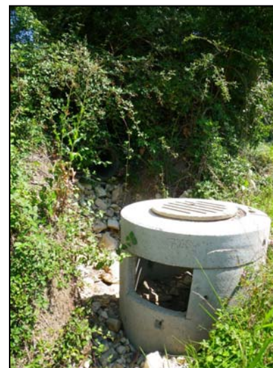
Érosion du fossé, contournement du piège à matériaux installé
