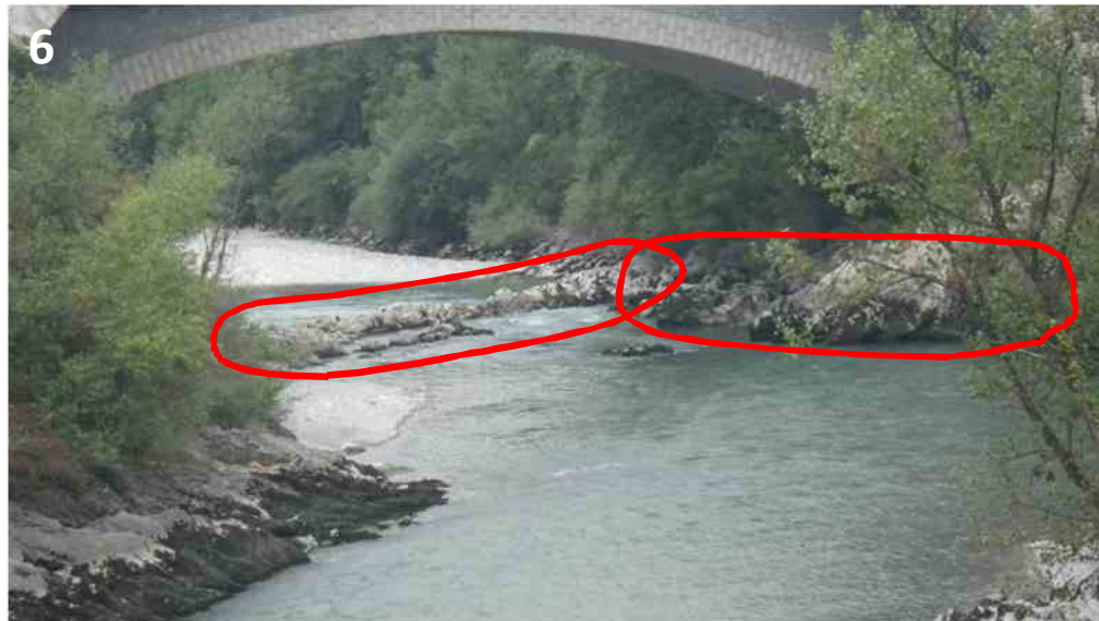
Déroctage potentiel en rive droite sous les ponts et abaissement du seuil rocheux
