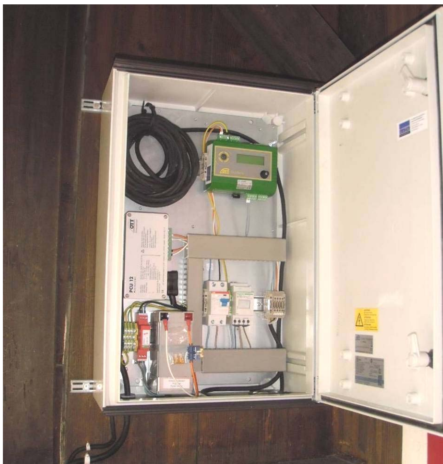
Figure 12 : Station d'alimentation / enregistrement des données
