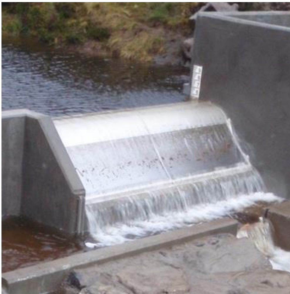
Prise d'eau Coanda – Photo de réalisation
