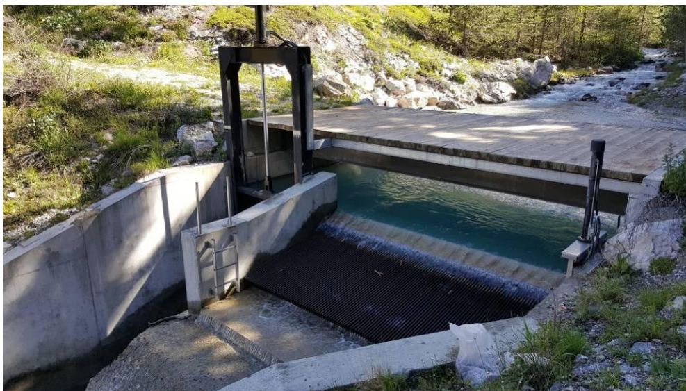
Figure 4 : Exemple de prise d'eau par en-dessous
