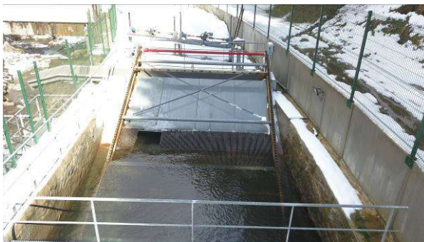
Figure 5: grilles inclinaison 26°, espacement des barreaux de 15mm et échancrure de dévalaison
