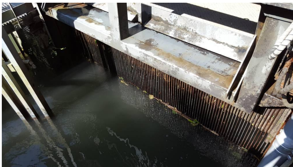
Figure 3 : Vue de la grille finisseuse de la PE de Pontcharin – Espacement des barreaux 20 mm
