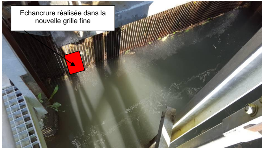
Figure 13 : Principe envisagé pour la dévalaison
