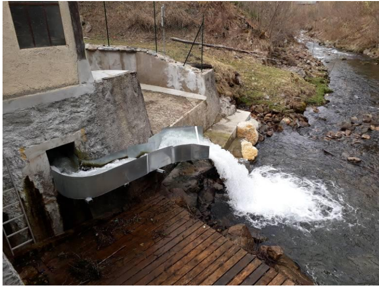
Figure 16 : Exemple de goulotte de dévalaison
