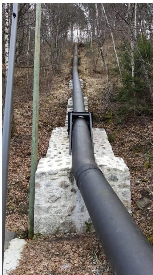
Arrivée de la conduite forcée à la centrale
