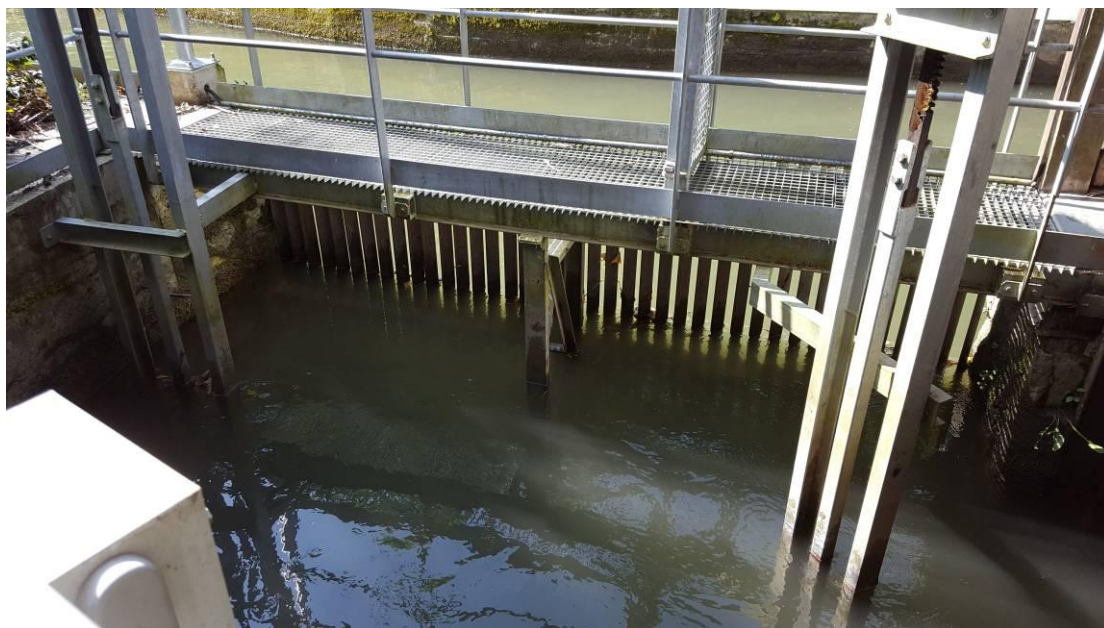
Figure 2 : Vue des pré-grilles de la PE de Potcharin - Espacement des barreaux 55 mm
