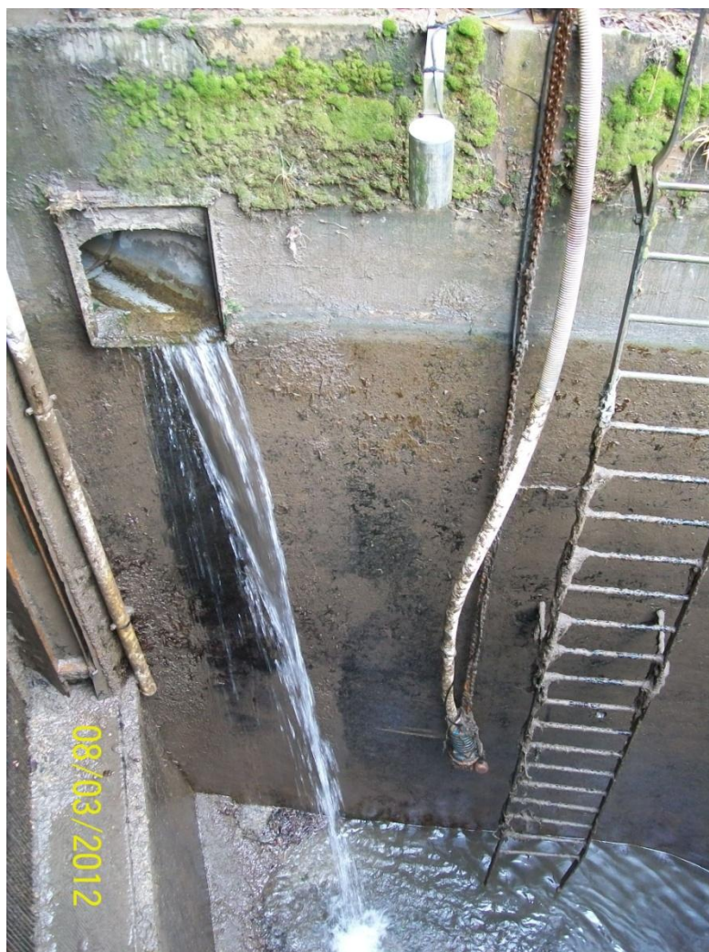
Arrivée de la prise d'eau en amont des grilles de prise dans la retenue de Pontcharin
