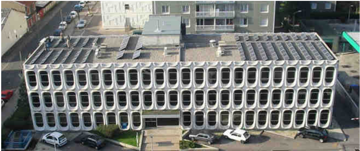
Figure 56 - exemple de ce bâtiment où les panneaux photovoltaïques sur toit plat sont orientés perpendiculairement au bâtiment.
