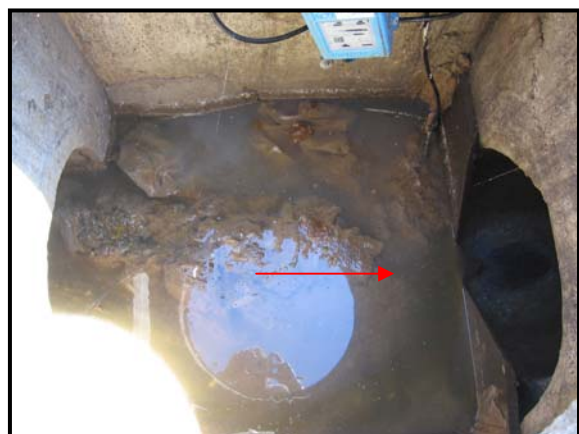
Point de mesure 4 – Seuil + Sonde de Pression
