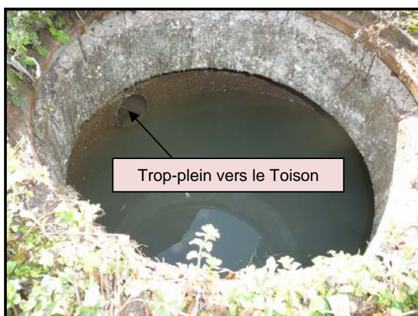
Vue du trop-plein au droit du regard juste en amont de la STEP sur le réseau
