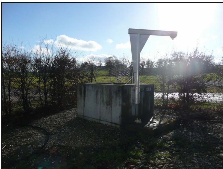
Vue du trop-plein au droit du regard juste en amont de la STEP sur le réseau
