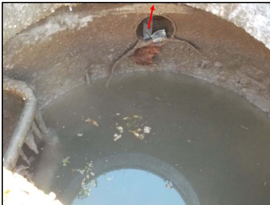
Mise en charge du réseau en amont du poste de la STEP
