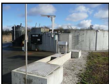
Canal Venturi en sortie de STEP
