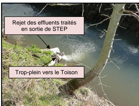
Vue du trop-plein au droit du regard juste en amont de la STEP sur le réseau
